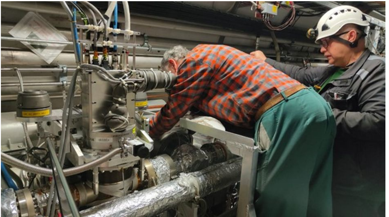
Fig.15 – Installazione di uno dei rivelatori sul LHC
